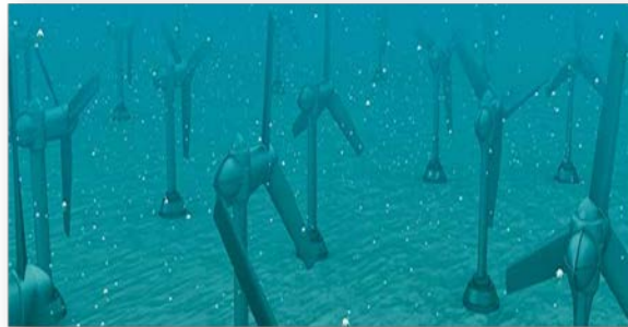
Figura 104: As turbinas de maré modernas operam como turbinas eólicas subaquáticas, convertendo as correntes de maré em energia elétrica 138 .
