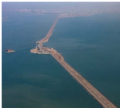
Figura 94: Localizada na Coreia do Sul, a Central Maremotriz do Lago Sihwa, concluída em 2011, é a maior instalação de energia maremotriz do mundo, com uma capacidade de 254 MW.
