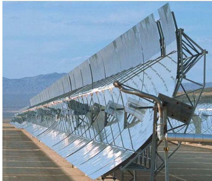
Figura 50: Os coletores parabólicos concentram a luz solar num tubo central para produzir calor a alta temperatura para a geração de eletricidade.
