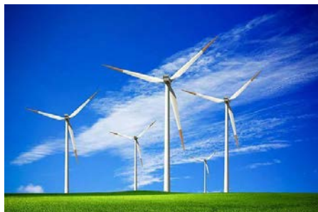
Figura 66: As turbinas eólicas de eixo horizontal são o tipo de turbina mais utilizado, sendo ideais para parques eólicos de grande dimensão e de elevada produção de energia.
