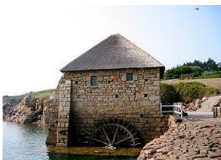
Figura 102: Os moinhos de corrente de maré convertem a energia cinética dos fluxos de maré em energia mecânica, historicamente utilizada para moer grãos.
