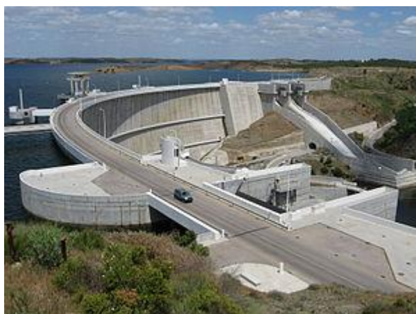
Figura 76: Barragem de Alqueva, Portugal. É uma das maiores barragens da Europa, gerando energia hidroelétrica e apoiando a irrigação
