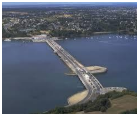
Figura 93: A Central Maremotriz de Rance, em França, com uma capacidade de 240 MW, é um dos primeiros e maiores projetos de energia maremotriz do mundo, operando com uma barragem de 750 metros.
