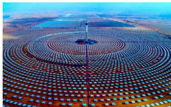
Figura 39: “Os sistemas de energia solar concentrada (ESC) utilizam espelhos para concentrar a luz solar e gerar eletricidade de forma eficiente.
